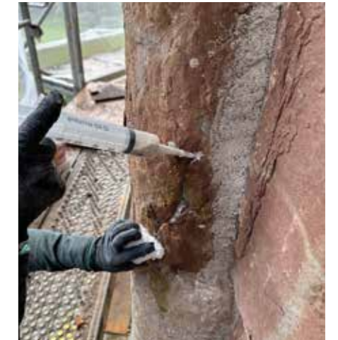
Injecció de morters. Imatge: 4restaure S.L.
