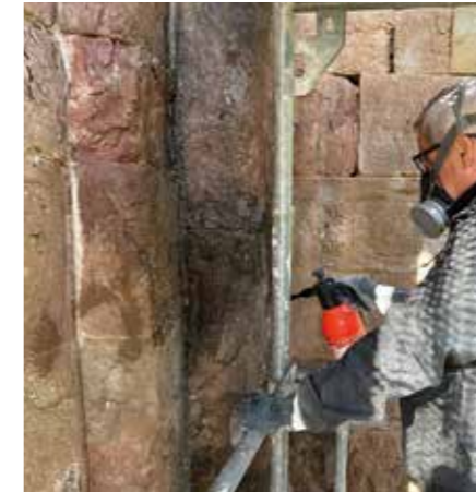
Tractament amb producte biocida. Imatge: 4restaure S.L.
